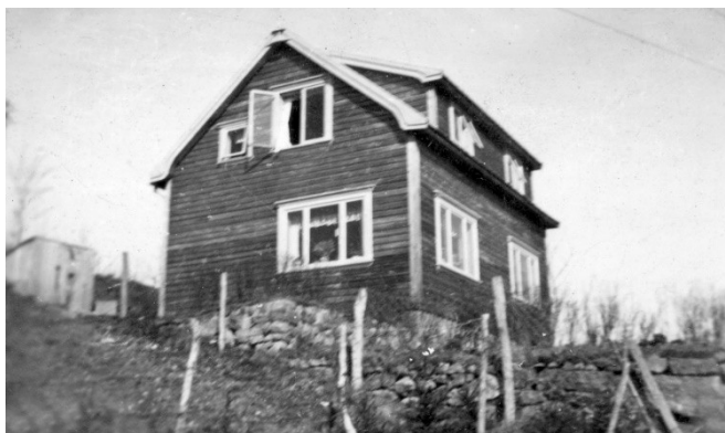
Slik så bolighuset ut da det var nybygget.
