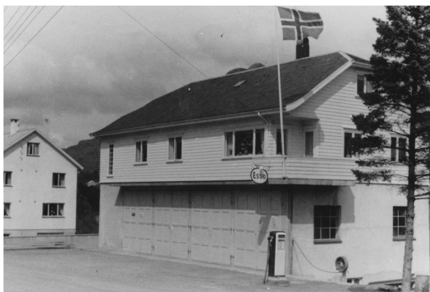
Garasje med plass til 4 busser og bolig ovenpå.
