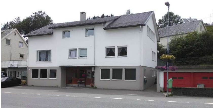
Bankbygget til Bjerkreim Sparebank fra 1960.
