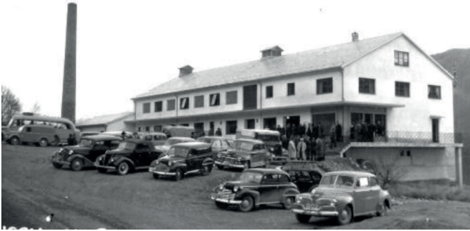
Meieriet ble nedlagt i 2012 og har stått ubrukt siden.
